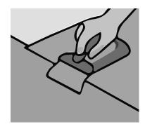
c. Asegurar la adhesión: Usa un rodillo de mano o una pisadera para presionar la alfombra firmemente contra el suelo y asegurar una buena adhesión al adhesivo.
