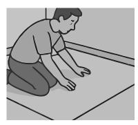
d. Fijar y ajustar: Presiona la alfombra hacia las tiras de púas para que se enganche y ajusta para eliminar arrugas o pliegues.
