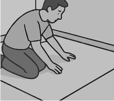
d. Fijar y ajustar: Presiona la alfombra hacia las tiras de púas para que se enganche y ajusta para eliminar arrugas o pliegues.
